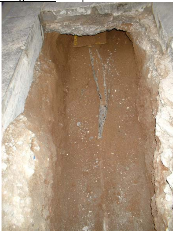
Fotografia 4: Vista del servei elèctric anterior que es va trobar a 60 cm de profunditat.
