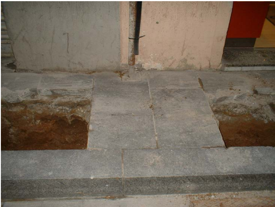
Fotografia 2: Pont de seguretat en els recolzaments de la bastida.
